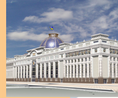
ВОКЗАЛЬНИЙ КОМПЛЕКС «ДАРНИЦЯ»
